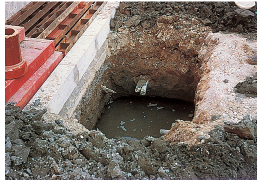
地下水位が高く植穴に水が溜まっている
